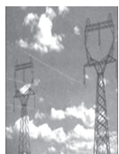
野外高压输电线 上方有两条与大 地相连的导线
